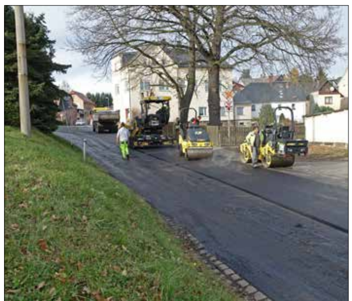
Durchführung von großflächigen Straßeninstandsetzungsarbeiten durch das Straßenbauamt Ostthüringen in der Ortslage Reudnitz
