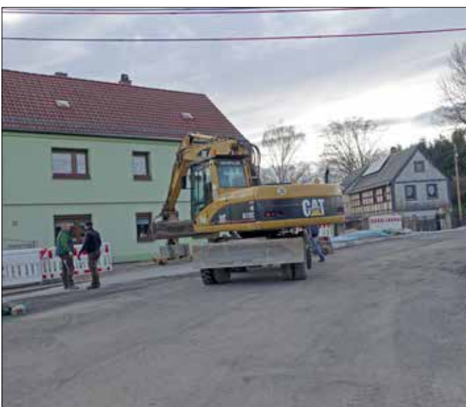
Der Ersatzneubau der Brücke über den Aubach in der Ortslage Reudnitz im Bereich der Landesstraße L1086 kurz vor der Fertigstellung
